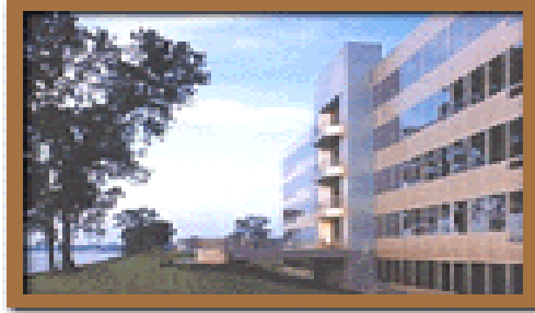
Figura 7. Fachada cortina de alumínio.
